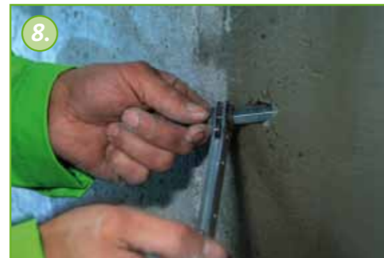
8. Pakningen strammes med en skrueøgle.
