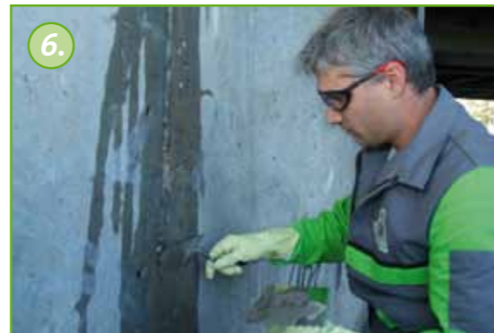
6. Revneforløbet lukkes med KÖSTER KB-Fix 5. Lukning af revnen forhindrer injektionsmaterialet i at flyde for tidligt ud af revnen under injektionen. Forarbejdningstiden er ca. 5 minutter afhængigt af omgivelsernes temperatur og luftfugtighed.
